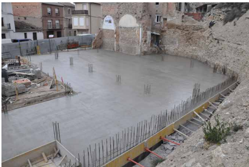
Plancha de hormigón
